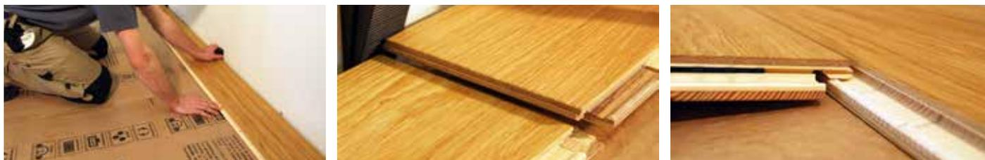
Die Abschnitte der jeweils vorhergehenden Reihe können als erste Diele der nächsten Reihe verwendet werden, sofern diese noch eine Mindestlänge von 30 cm aufweisen. Ab der zweiten Reihe werden die Dielen längsseitig in einem Winkel von 30° in die Nut der vorigen Reihe gelegt und anschließend nach unten geklappt. Der Versatz zwischen Stirnstößen benachbarter Reihen muss mind. 50 cm betragen. Achten Sie dabei auf eine korrekte Verriegelung.
